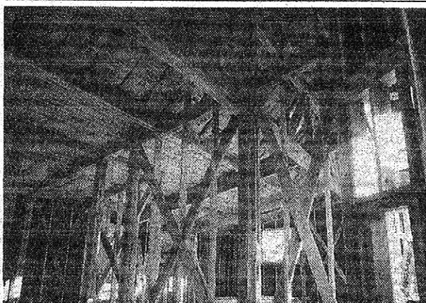
建設中の園舎
